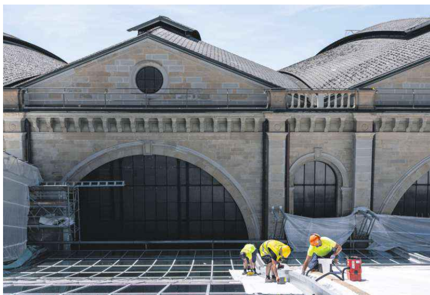
Die Bundesbahnen produzieren seit Jahrzehnten einen erheblichen Teil ihres Stroms selbst – allerdings vor allem mit Wasserkraft. Im Bild Bauarbeiten am Glasdach des Nordtraktes am Zürcher HB.
